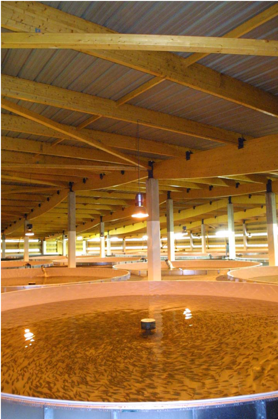
Salle de grossissement des smolts au CNSS
