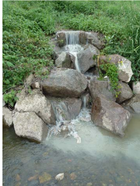
Rejet de la station d'épuration du Breuil-sur-Couze (03/06/11)
